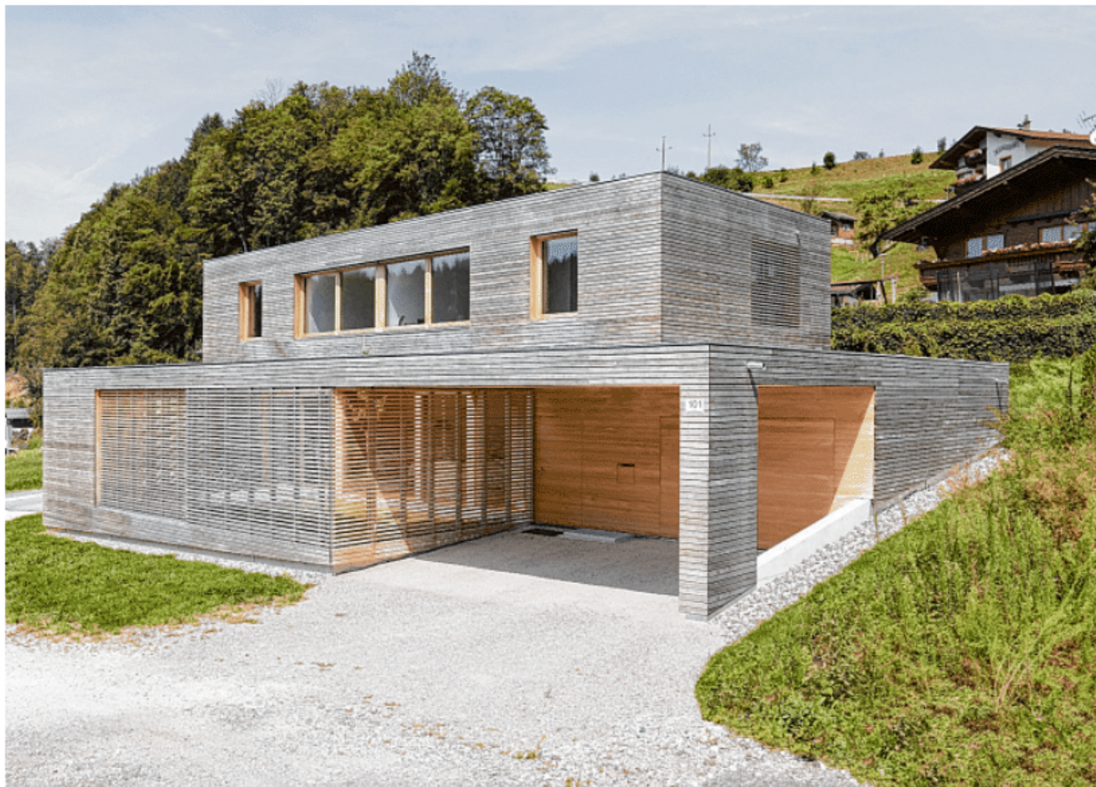
Der Baukörper ist außen zur Gänze horizontal mit sägerauen bzw. glatt gehobelten Latten aus Weißtanne verschalt.
